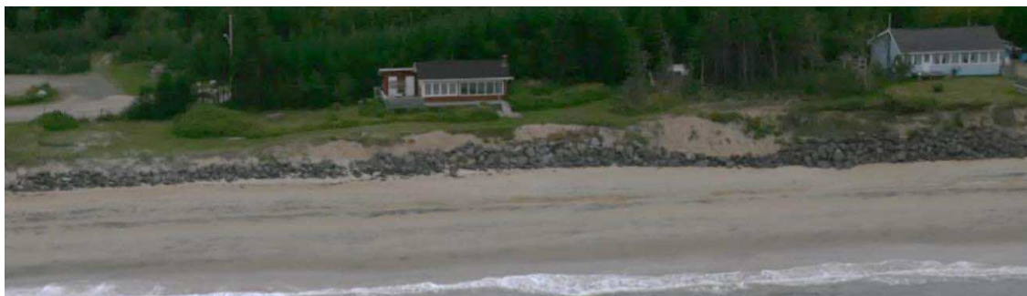
Érosion graduelle malgré la présence d'un enrochement (Sept-Îles), septembre 2010
