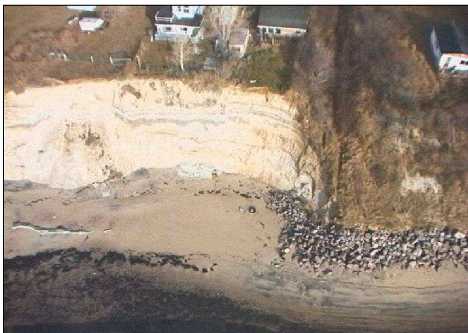
Figure 3 - Travaux d'enrochement et effet de bout. (Photo, MSP, 2000).
