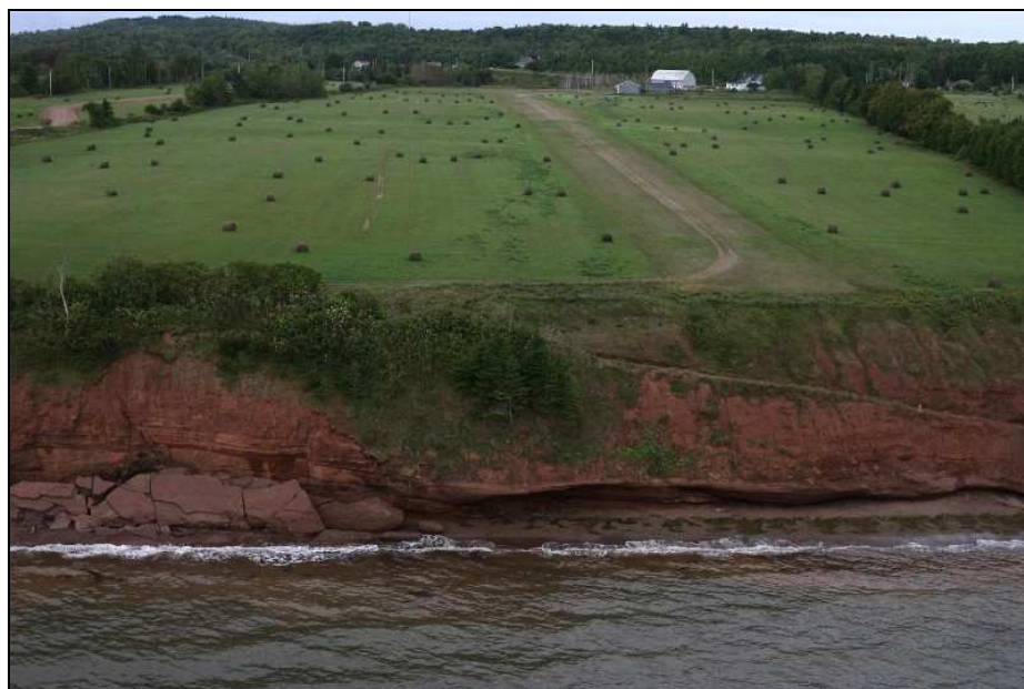
Figure 8 – Exemple de rupture par basculement. (Photo,UQAR, 2010).
